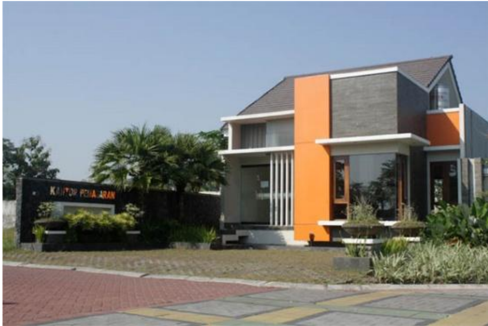
Gambar 5.4 Halaman rumah dan jalan lingkungan menggunakan paving block dan grass block yang mudah meresapkan air ke tanah.
