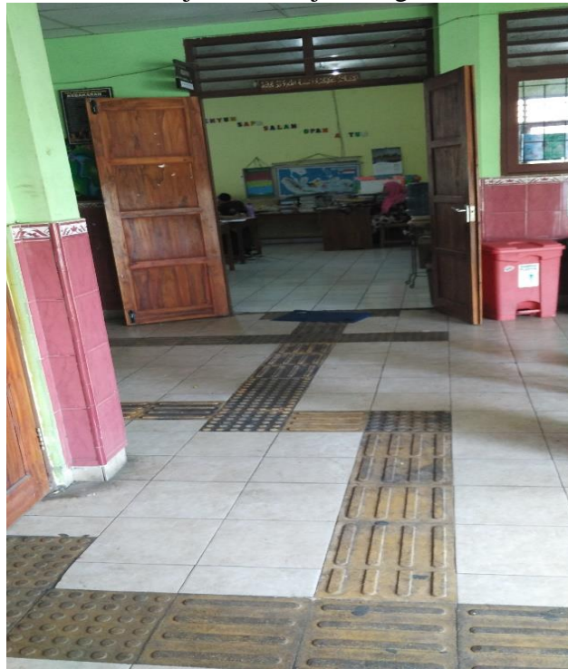
Gambar 3.6 Akses jalan menuju ruang kelas
