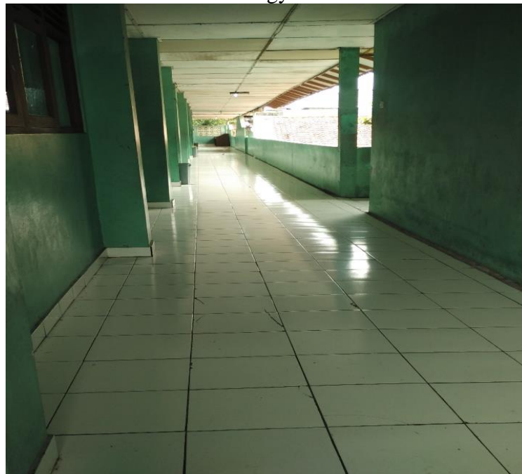
Gambar 3.9 Kondisi jalan dan lantai menuju kelas di sekolah SMP 9 Muhammadiyah Kota Yogyakarta
