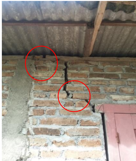
Gambar 4.7 Dinding bangunan ( Sumber : Survei Lapangan 2018 )
