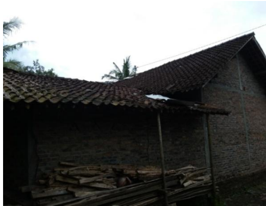
Gambar 4.36 Split Level pada bagian atap ( Sumber : Survei Lapangan 2018 )
