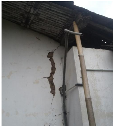
Gambar 4.54 Dinding bangunan ( Sumber : Survei Lapangan 2018 )
