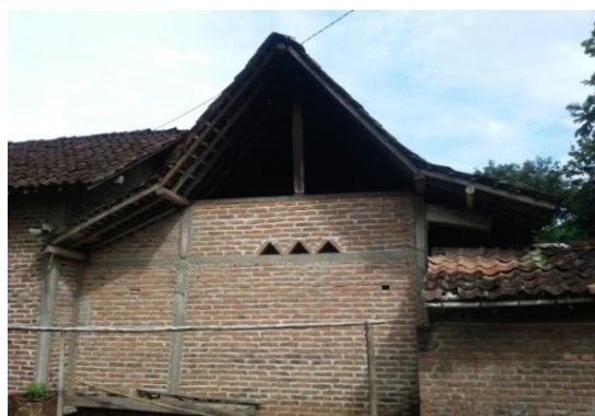
Gambar 4.25 Split Level pada bagian atap ( Sumber : Survei Lapangan 2018 )
