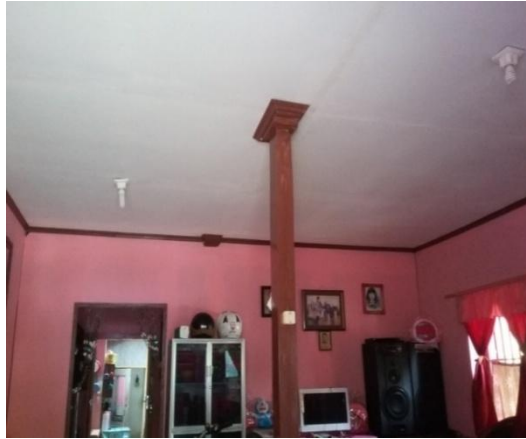
Gambar 4.51 Penutup Plafon ( Sumber : Survei Lapangan 2018 )
