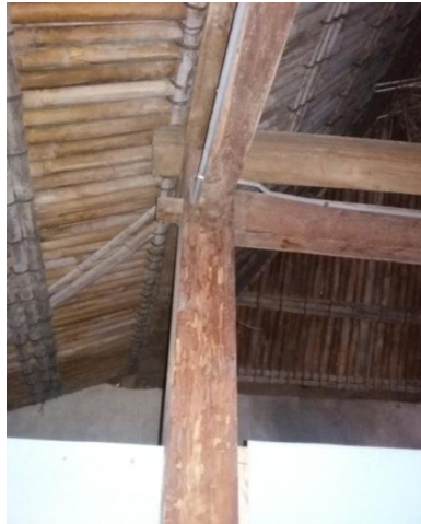
Gambar 4.23 Konstruksi kayu ( Sumber : Survei Lapangan 2018 )
