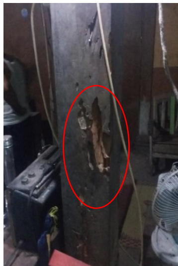
Gambar 4.41 Konstruksi kayu ( Sumber : Survei Lapangan 2018 )
