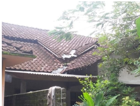
Gambar 4.19 Split Level pada bagian atap ( Sumber : Survei Lapangan 2018 )
