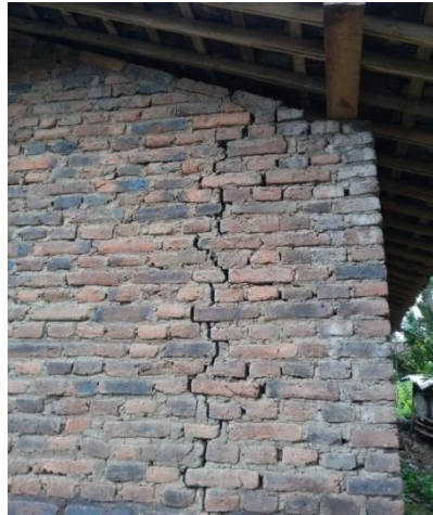
Gambar 4.40 Dinding bangunan ( Sumber : Survei Lapangan 2018 )
