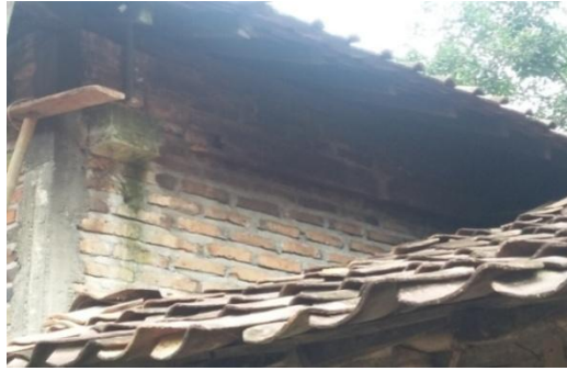
Gambar 4.14 Split Level pada bagian atap ( Sumber : Survei Lapangan 2018 )
