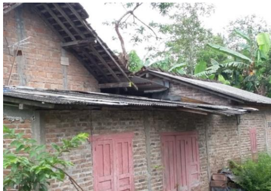
Gambar 4.5 Split Level pada bagian atap ( Sumber : Survei Lapangan 2018 )
