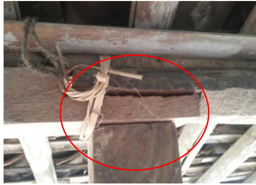
Gambar 4.48 Sambungan balok kayu ( Sumber : Survei Lapangan 2018 )
