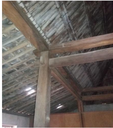
Gambar 4.30 Konstruksi kayu ( Sumber : Survei Lapangan 2018 )
