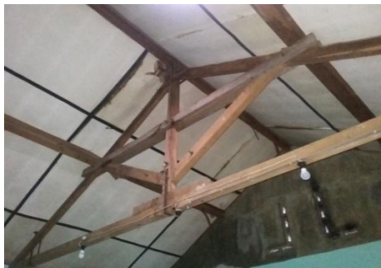
Gambar 4.4 Struktur kuda-kuda kayu ( Sumber : Survei Lapangan 2018 )
