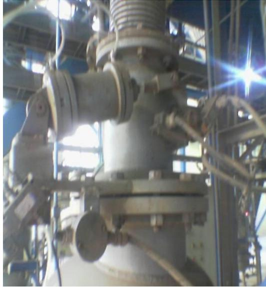
Gambar 2.13 Bagian luar ash inlet valve
