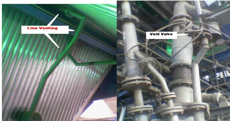
Gambar 2.16 Line Venting dan Vent valve
