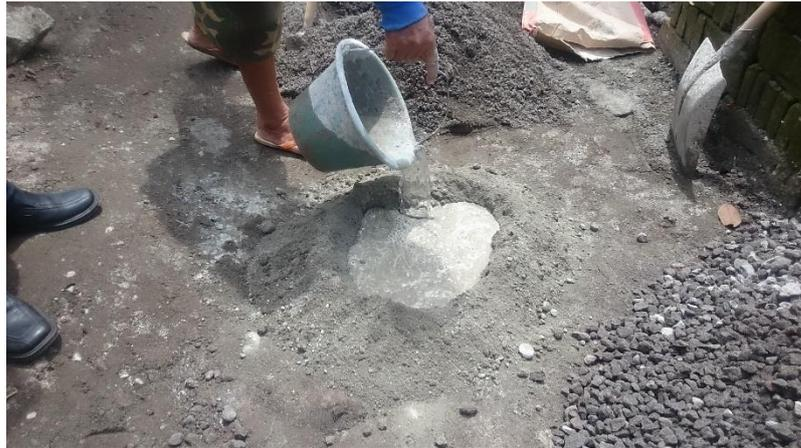
Gambar 3.6. Proses pencampuran pasir + semen + air
