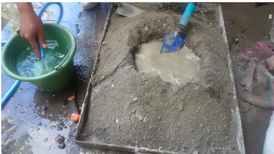
Gambar 3.21. Proses pencampuran semen + pasir + air
