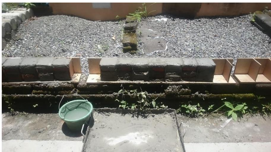
Gambar 3.23. Proses pencetakan Batu bata + plesteran
