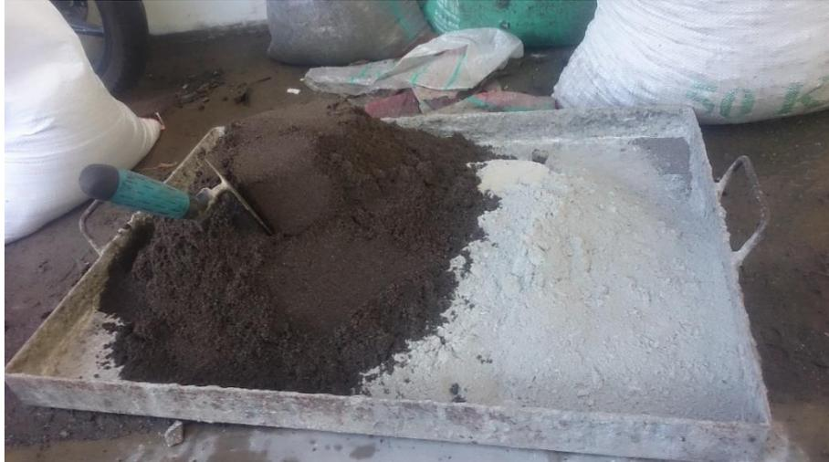
Gambar 3.19. Proses pencampuran semen + pasir
