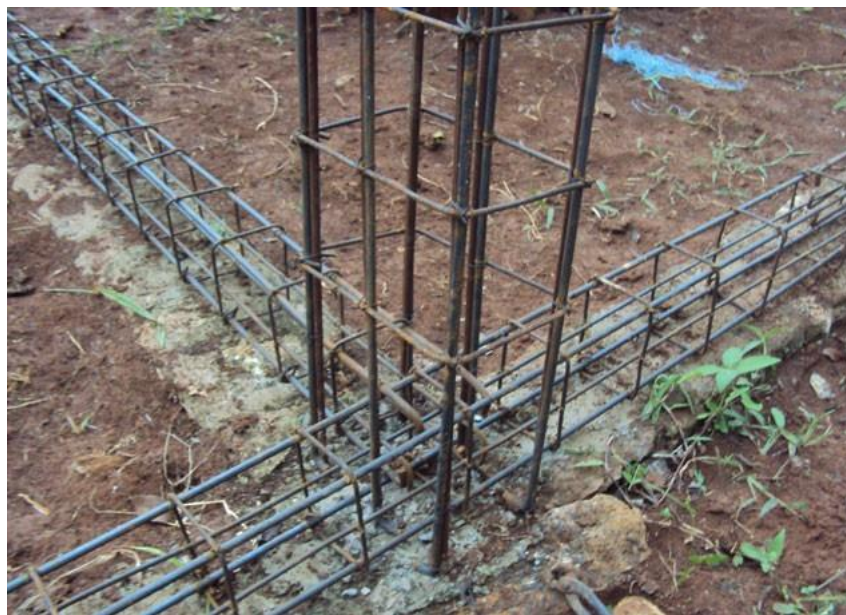
Gambar 4.12. Sambungan sloof dengan kolom praktis
