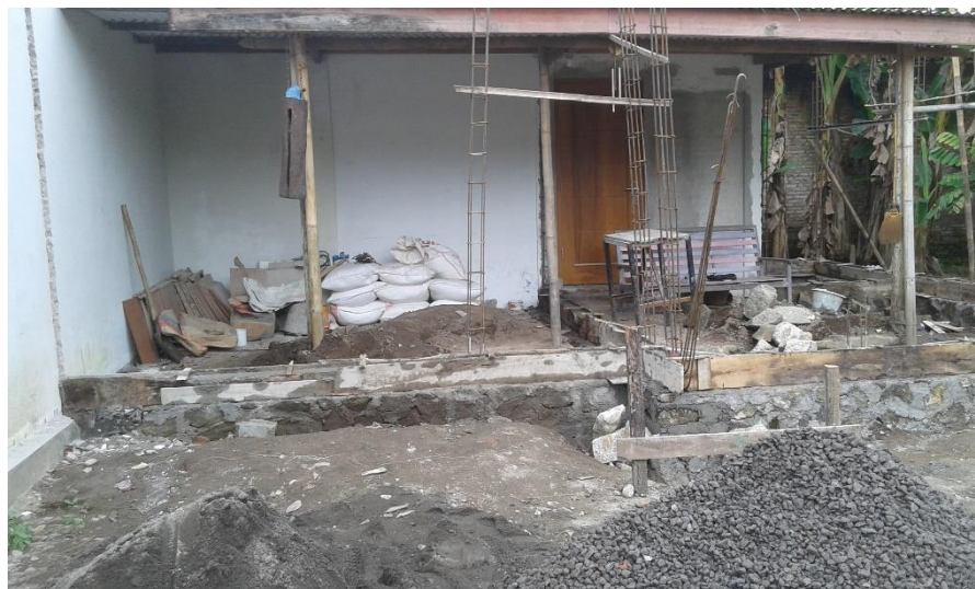
Gambar 4.14. Proses pembuatan balok praktis/ ringbalk
