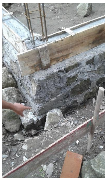
Gambar 4.11. Pondasi pasangan batu kali.
