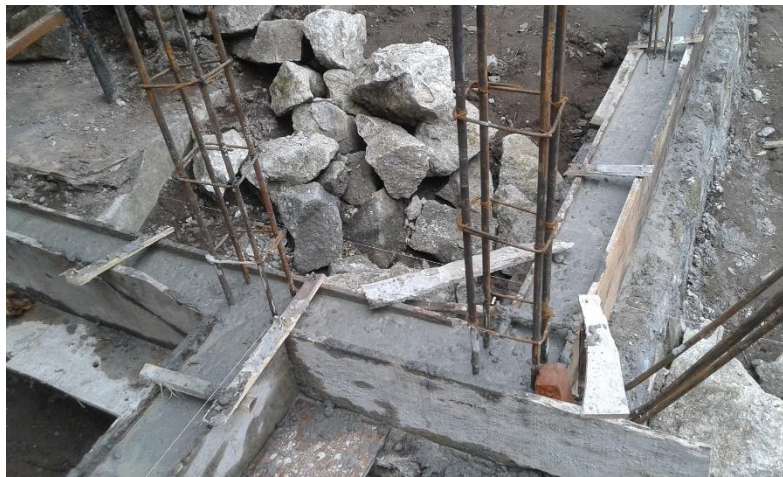
Gambar 4.13. Proses pembuatan kolom praktis
