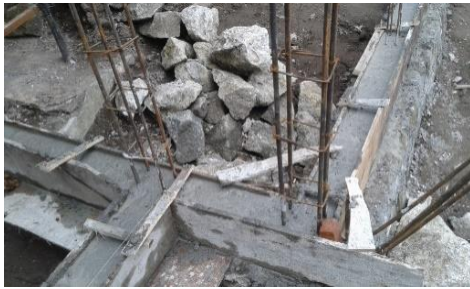
Gambar 9 Pembuatan kolom praktis
