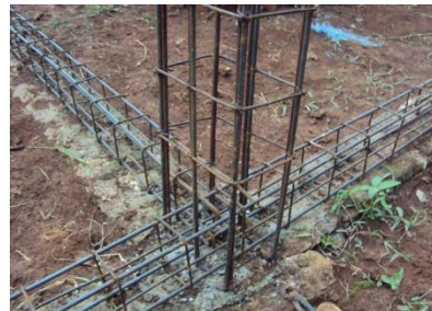
Gambar 8 sambungan sloof dengan kolom praktis
