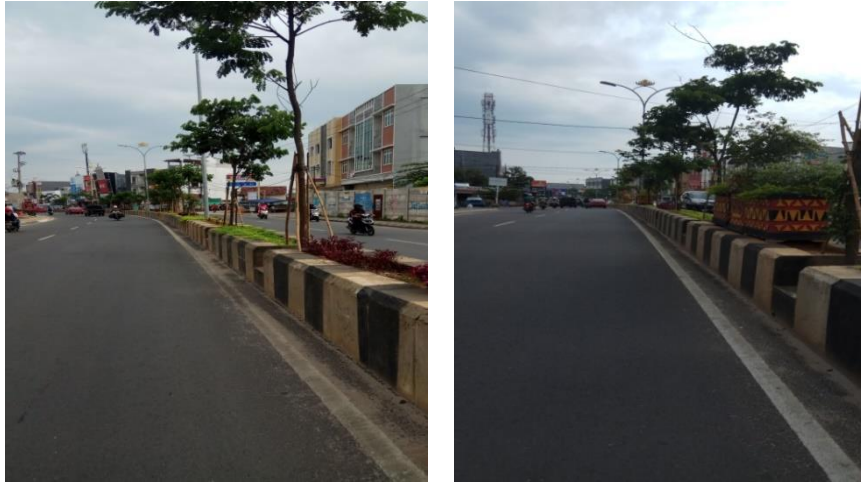
Gambar 3. Kondisi Jalan Gajah Mada
