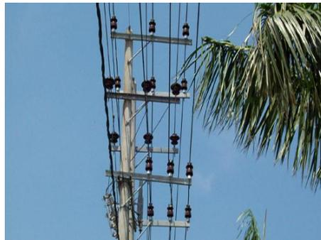
**Gambar 2.10** Saluran Udara Tegangan Rendah
