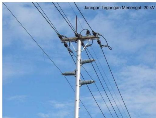
**Gambar 2.6** Saluran Kabel Udara Tegangan Menengah
