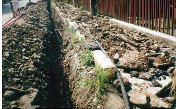
**Gambar 2.7** Saluran Kabel Tegangan Menengah
