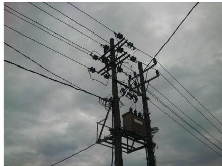
**Gambar 2.5** Saluran Udara Tegangan Menengah
