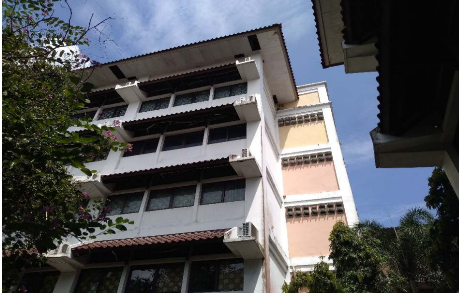
Gambar 4.3 Gedung F3 Fakultas Teknik.
