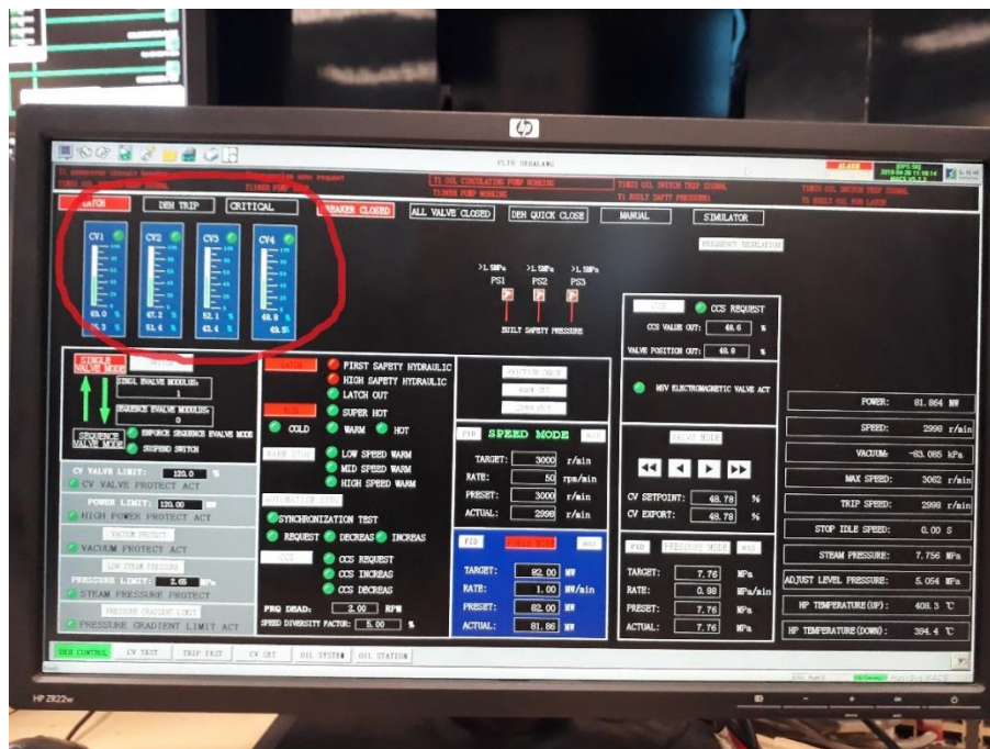
Gambar 4.2 Pengaturan Governor Dari Ruang Kontrol
