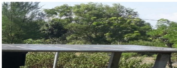
(Sumber : Dokumentasi pribadi) Gambar 4.4 Panel surya grup timur Jenis Monokristal
