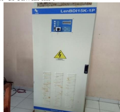
Gambar 4.9 Inverter len BDI15K-1P 15 kw 240 V (Sumber: Dokumentasi pribadi)
