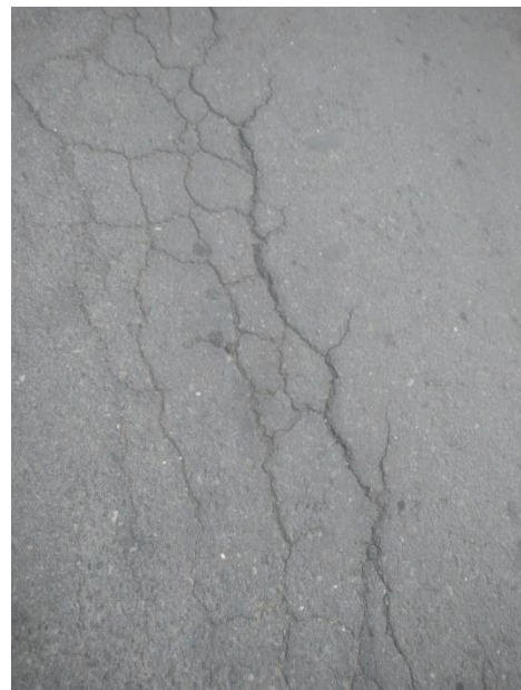
Gambar 4.61. Retak kulit buaya
