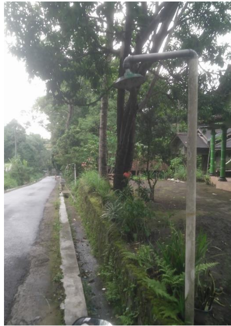
Gambar 4.3. Penerangan jalan, bahu jalan, dan drainase
