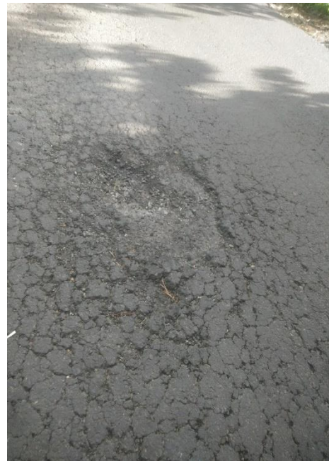
Gambar 4.49. Retak kulit buaya
