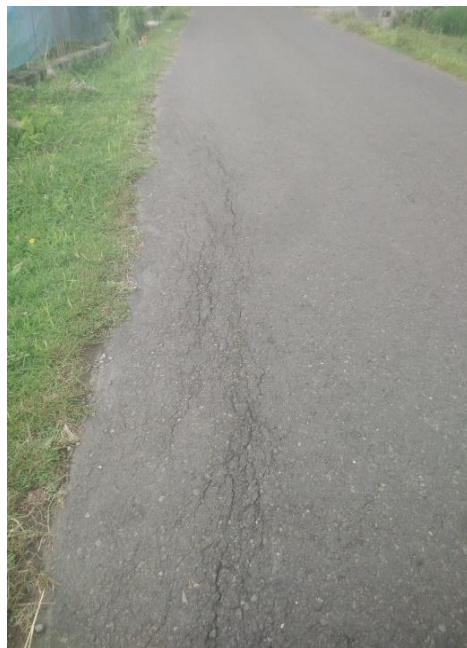
Gambar 4.56. Retak kulit buaya
