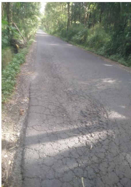
Gambar 4.50. Retak pinggir
