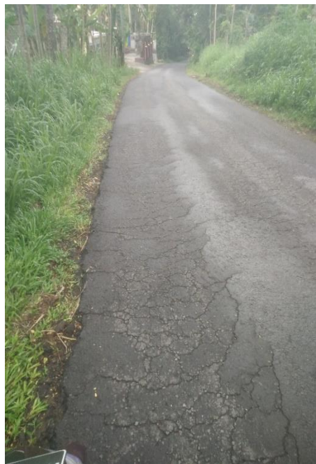
Gambar 4.45. Retak kulit buaya
