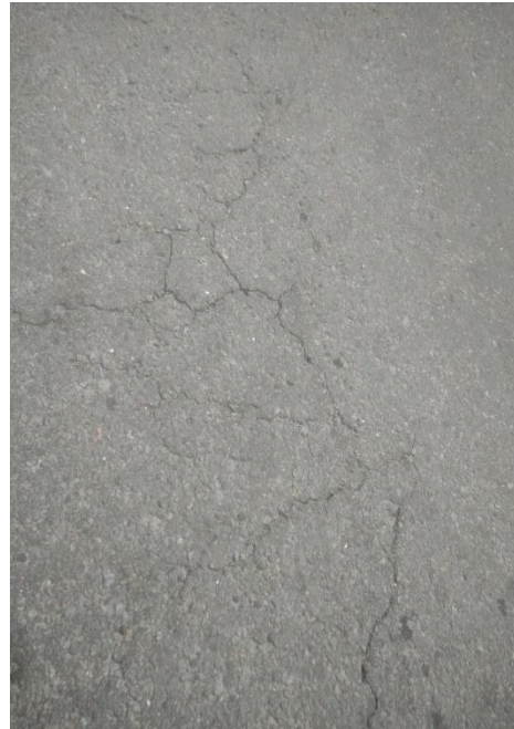
Gambar 4.55. Retak kulit buaya
