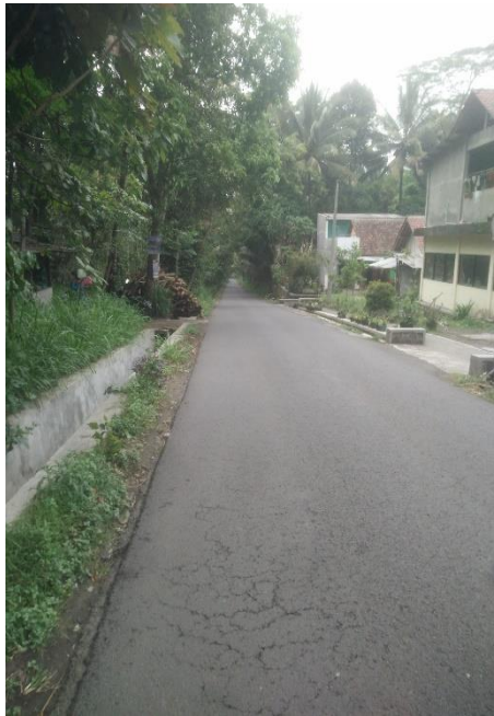
Gambar 4.10. Kondisi jalan jalur evakuasi segmen 2
