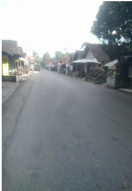
Gambar 4.16. Kondisi jalan jalur evakuasi segmen 3
