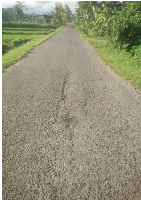
Gambar 4.54. Retak kulit buaya
