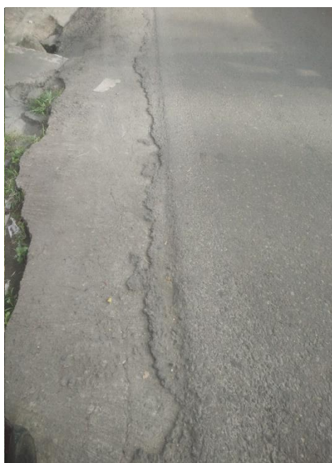
Gambar 4.51. Retak pinggir
