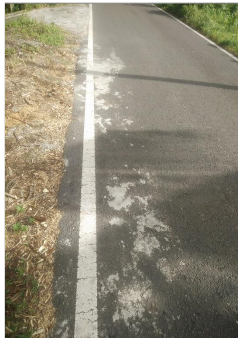
Gambar 4.59. Retak pinggir
