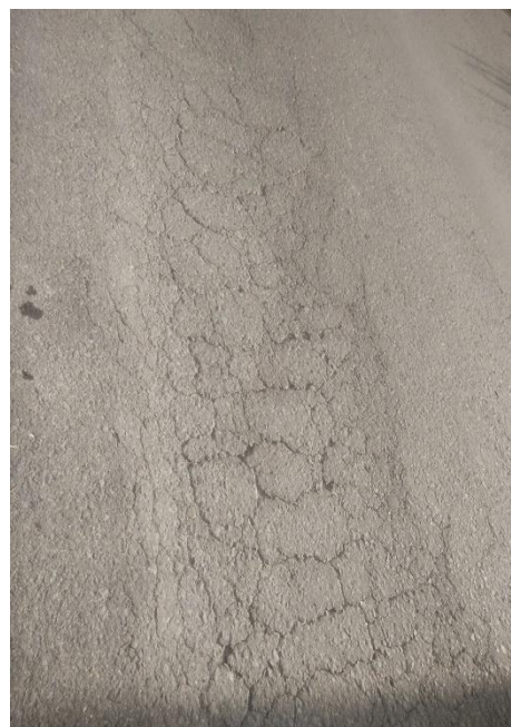
Gambar 4.52. Retak kulit buaya
