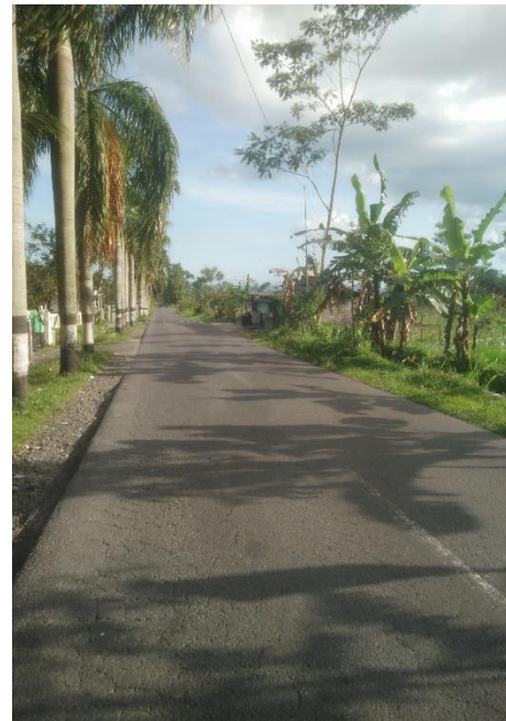
Gambar 4.17. Kondisi jalan jalur evakuasi segmen 3
