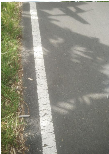
Gambar 4.58. Retak pinggir
