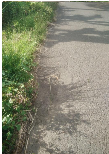
Gambar 4.57. Retak pinggir
