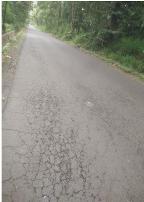
Gambar 4.48. Retak kulit buaya
