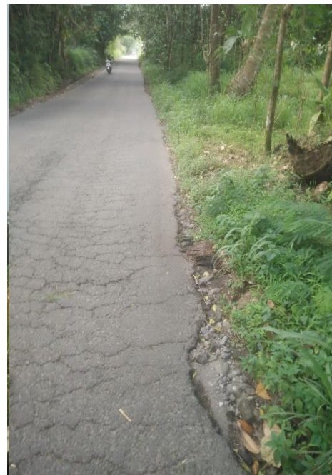
Gambar 4.46. Retak pinggir
