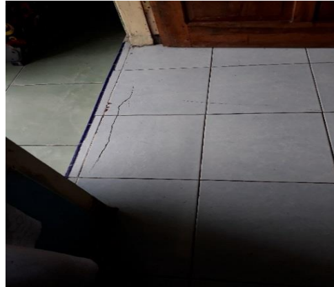
Gambar 4.18 Sampel rusak penutup lantai keramik pada salah satu rumah di Huntap Karangkendal
