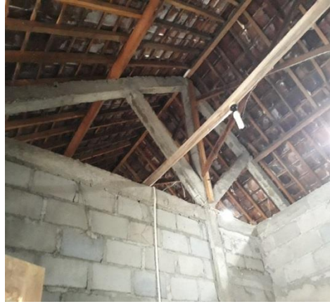
Gambar 4.42 Sampel penutup atap pada salah satu rumah di Huntap Pagerjurang
