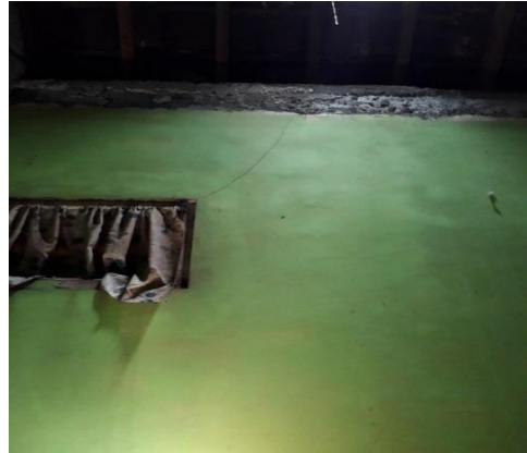
Gambar 4.16 Sampel retak pada dinding salah satu rumah di Huntap Karangkendal
