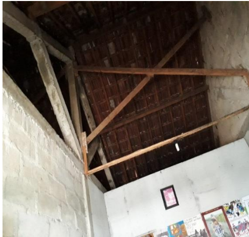
Gambar 4.65 Sampel kuda kuda pada salah satu rumah di Huntap Batur
