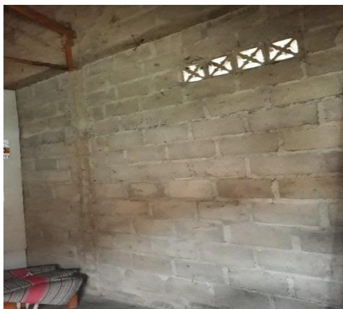
Gambar 4.67 Sampel dinding tanpa plasteran pada salah satu rumah di Huntap Batur
