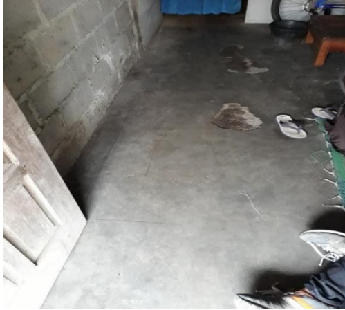
Gambar 4.63 Sampel penutup lantai plasteran pada salah satu rumah di Huntap Batur
