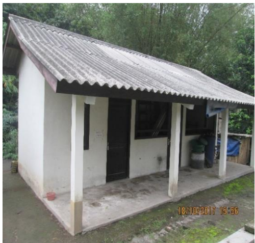
Gambar 4.61 Tempat pengolahan sampah terpadu
