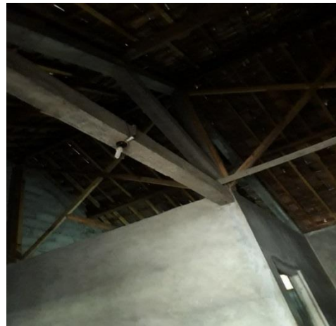
Gambar 4.82 Sampel dinding dengan plasteran pada salah satu rumah di Huntap Plosokerep
