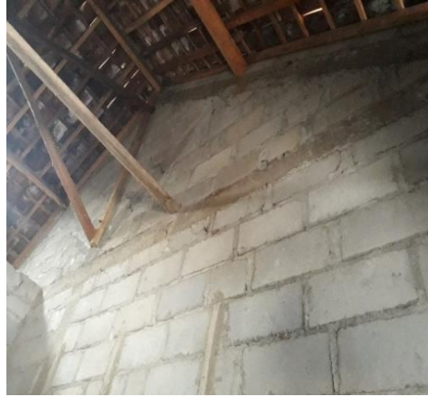
Gambar 4.44 Sampel dinding tanpa plasteran pada salah satu rumah di Huntap Pagerjurang
