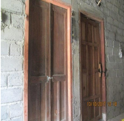
Gambar 4.13 Kondisi kusen pintu dan jendela.
