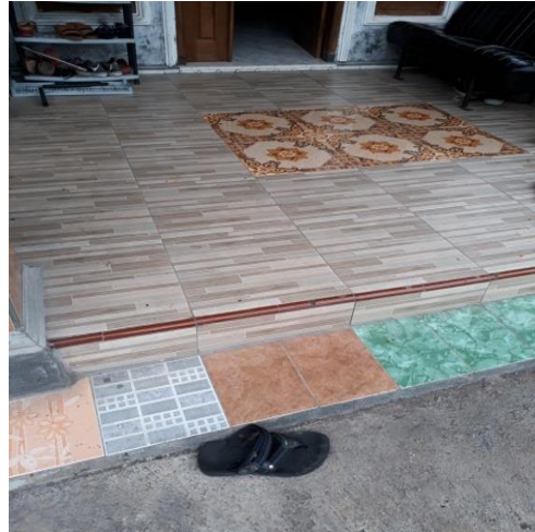
Gambar 4.70 Kondisi lantai dengan penutup lantai keramik.
