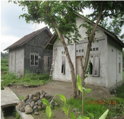
Gambar 4.36 Bangunan rumah tinggal yang belum mengalami renovasi.
