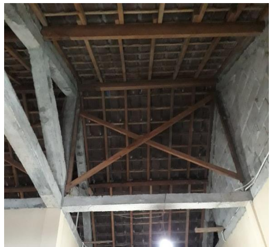
Gambar 4.134 Kondisi penutup atap.
