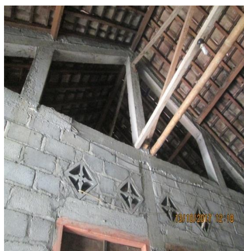
Gambar 4.12 Kondisi rangka atap bangunan.
