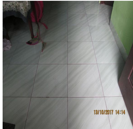
Gambar 4.43 Bangunan dengan penutup lantai berupa keramik.
