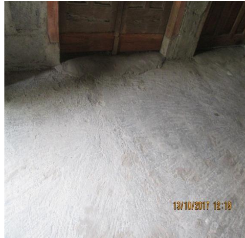
Gambar 4.14 Kondisi lantai dengan penutup lantai plesteran.
