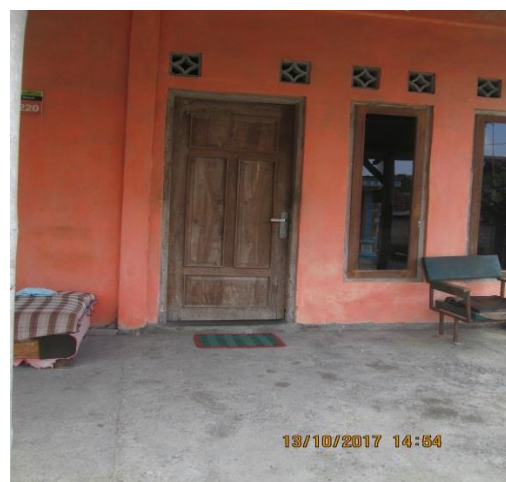
Gambar 4.94 Kondisi lantai dengan penutup lantai plesteran.
