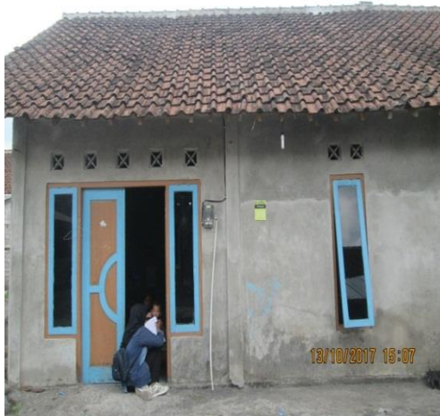
Gambar 4.91 Bangunan rumah tinggal yang belum mengalami renovasi.
