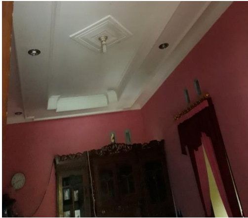
Gambar 4.75 Penambahan plafon pada bangunan rumah.
