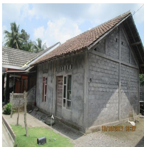
Gambar 4.11 Bangunan rumah tinggal yang belum mengalami renovasi.
