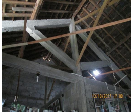
Gambar 4.124 Kondisi rangka atap bangunan.
