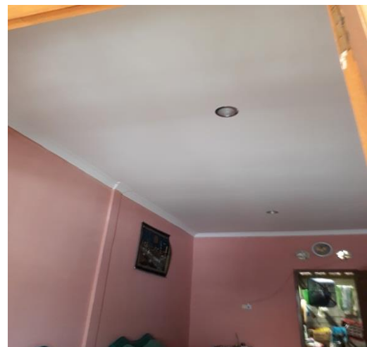
Gambar 4.100 Bangunan yang sudah dilengkapi dengan plafon.
