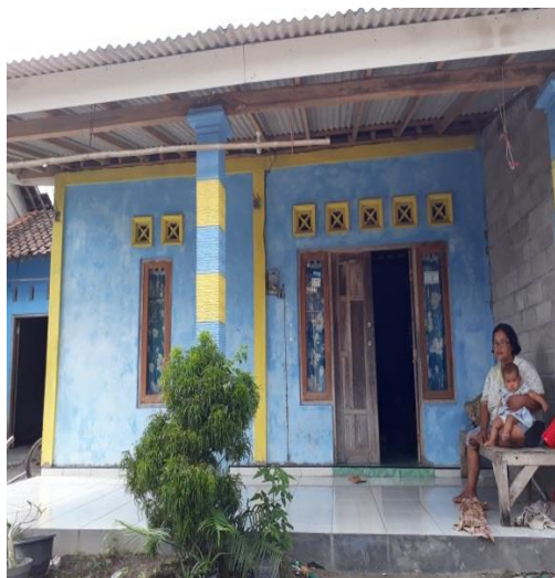
Gambar 4.101 Penambahan teras pada bangunan rumah.
