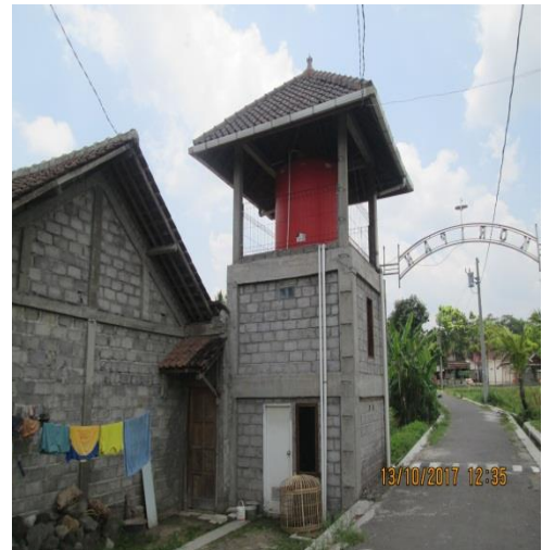
Gambar 4.6 Penampungan air bersih
