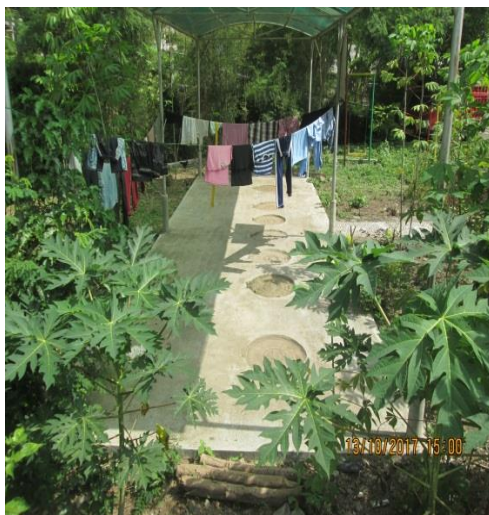
Gambar 4.85 Instalasi Pengolahan Air Limbah (IPAL Komunal)
