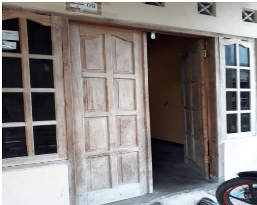
Gambar 4.125 Kondisi kusen pintu dan jendela.
