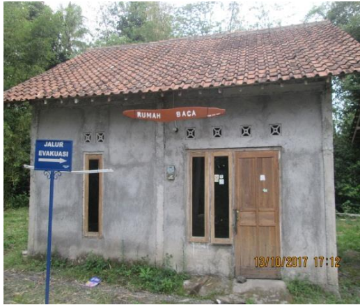
Gambar 4.123 Bangunan yang belum mengalami renovasi.
