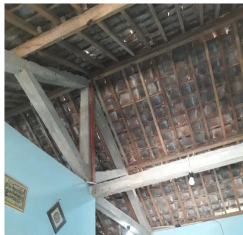
Gambar 4.68 Kondisi rangka atap bangunan.
