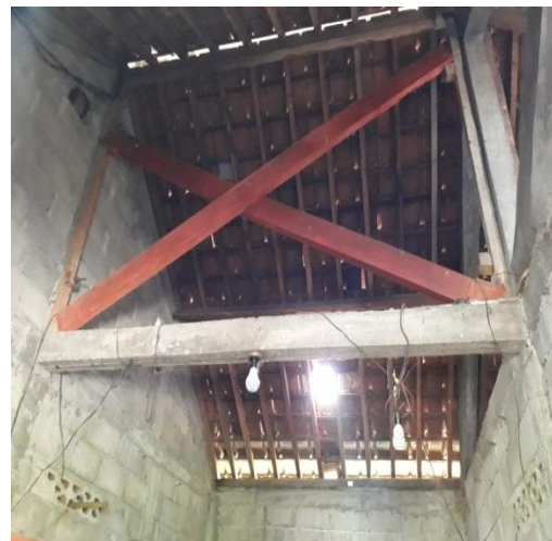
Gambar 4.47 Kondisi penutup atap.
