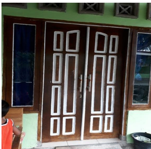
Gambar 4.99 Kusen pintu dengan material yang lebih baik.
