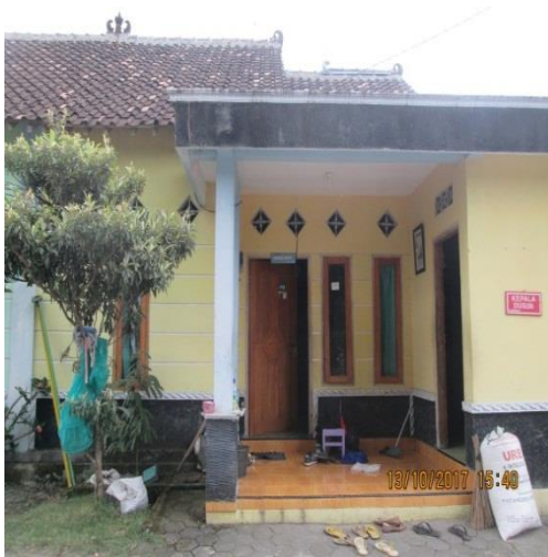
Gambar 4.71 Kondisi dinding dengan plesteran dan sudah di cat.
