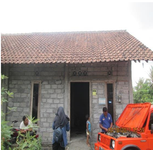
Gambar 4.67 Bangunan rumah tinggal yang belum mengalami renovasi.
