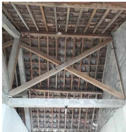
Gambar 4.102 Kondisi penutup atap.
