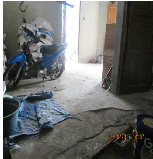
Gambar 4.39 Kondisi lantai dengan penutup lantai plesteran.
