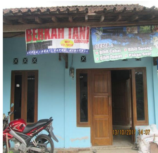
Gambar 4.41 Kondisi dinding dengan plesteran dan sudah di cat.
