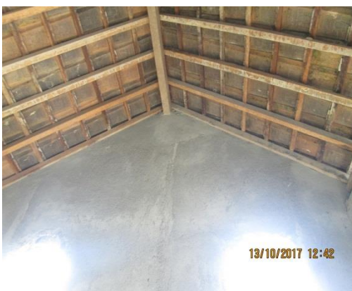
Gambar 4.22 Kondisi penutup atap.
