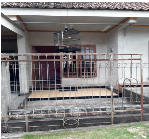
Gambar 4.131 Penambahan pagar pada bangunan rumah.
