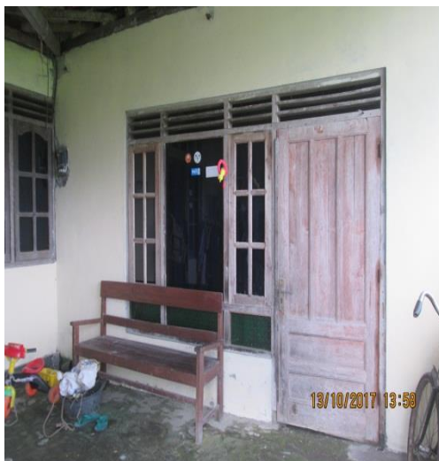
Gambar 4.38 Kondisi kusen pintu dan jendela.
