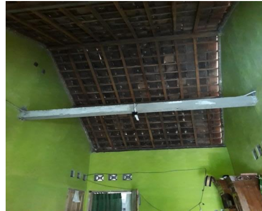
Gambar 4.78 Kondisi penutup atap.
