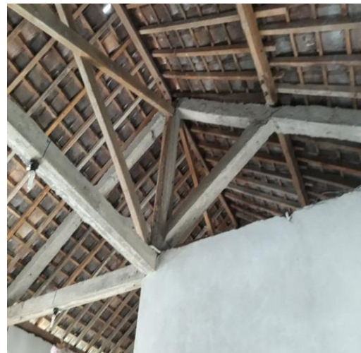
Gambar 4.92 Kondisi rangka atap bangunan.
