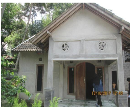
Gambar 4.21 Penambahan teras pada bangunan rumah.
