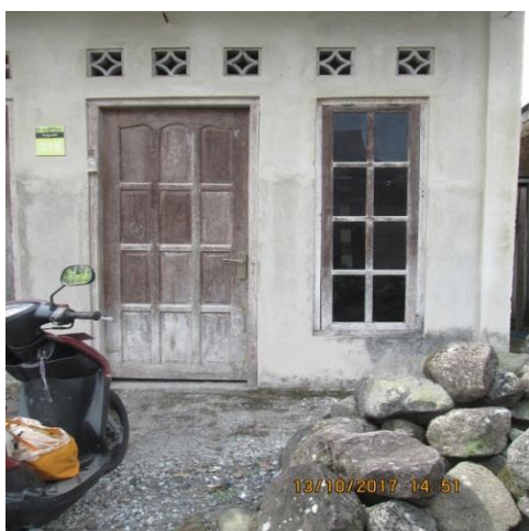
Gambar 4.93 Kondisi kusen pintu dan jendela.
