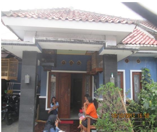
Gambar 4.127 Kondisi dinding dengan plesteran dan sudah di cat.
