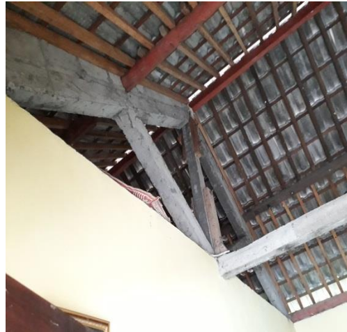
Gambar 4.37 Kondisi rangka atap bangunan.
