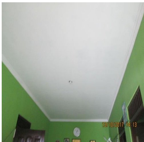
Gambar 4.46 Penambahan plafon pada bangunan rumah.
