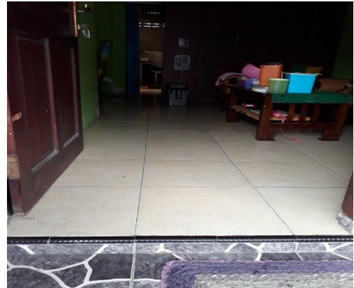
Gambar 4.126 Kondisi lantai dengan penutup lantai keramik.
