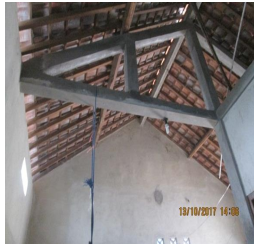
Gambar 4.45 Rangka atap yang sudah dilapisi dengan plesteran.
