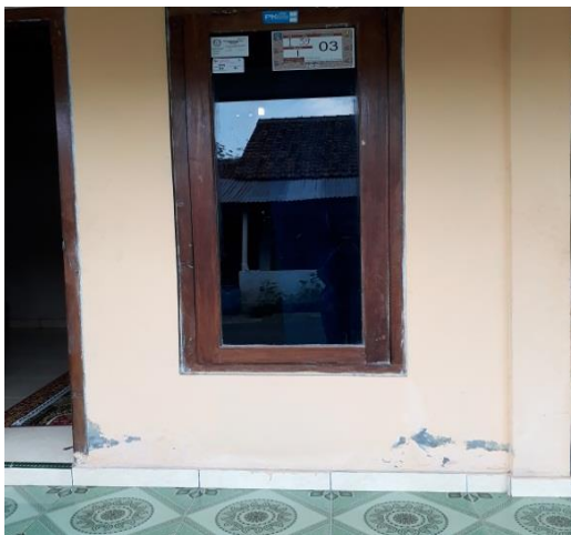
Gambar 4.133 Pengelupasan pada bagian cat dinding.
