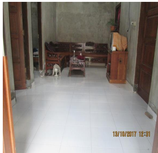
Gambar 4.18 Bangunan dengan penutup lantai berupa keramik.
