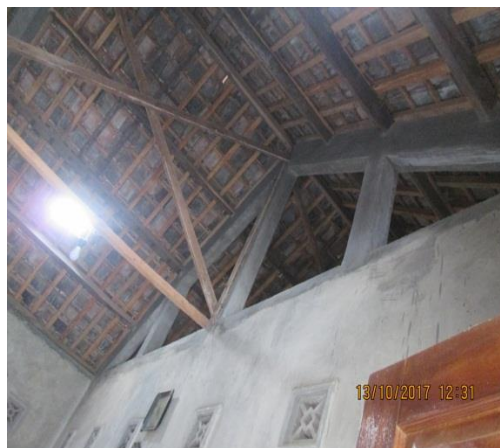
Gambar 4.20 Kondisi struktur kuda-kuda yang sudah dilapisi dengan plesteran.
