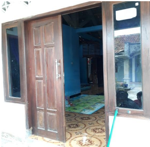
Gambar 4.69 Kondisi kusen pintu dan jendela.
