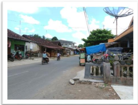
1. Kondisi Kemiringan Lereng dan Pemukiman
