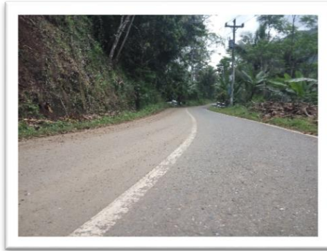
1. Kondisi Kemiringan Lereng
