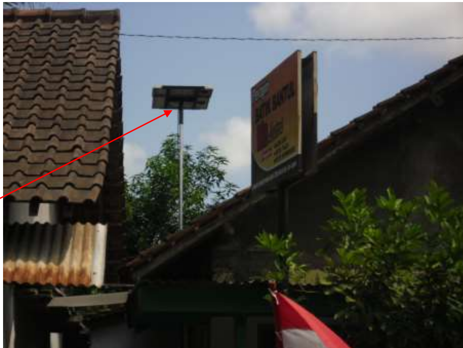
Gambar L.2. Solar cell panel telah terpasang di UKM Batik Ida Lestari.
