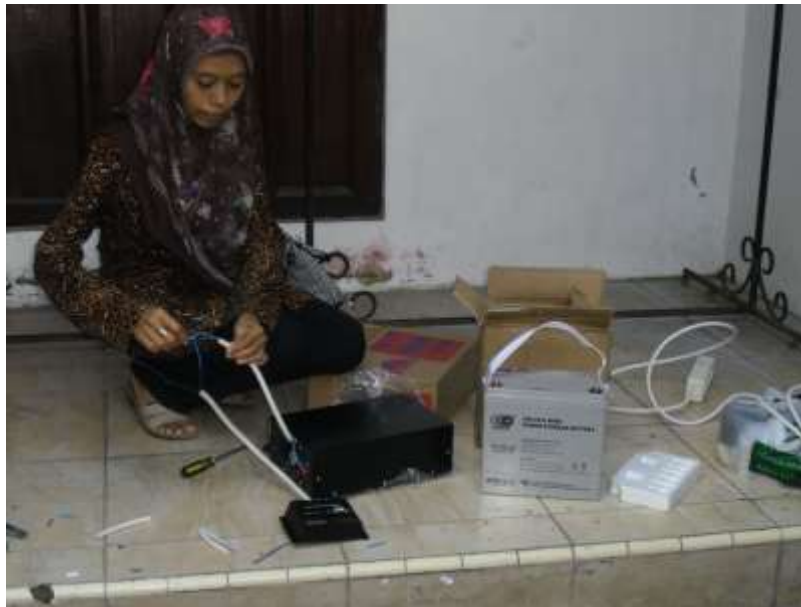
Gambar L.12. Perakitan solar controler dan inverter di PT Mahakarya Putra Indonesia oleh anggota tim IbPE.
