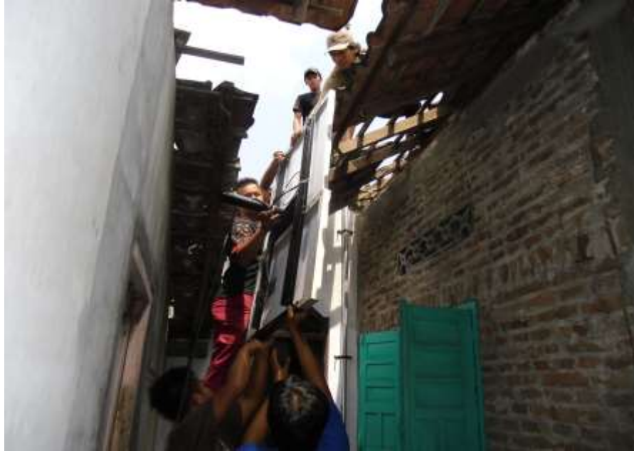
Gambar L.1. Pemasangan solar cell panel di UKM Batik Ida Lestari.
