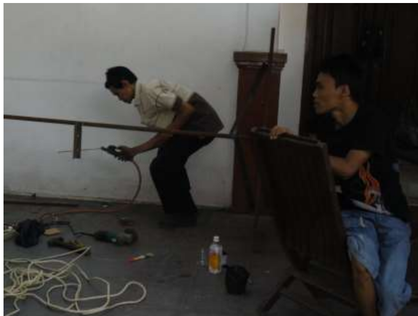
Gambar L.10. Pemasangan solar home system di PT Mahakarya Putra Indonesia.
