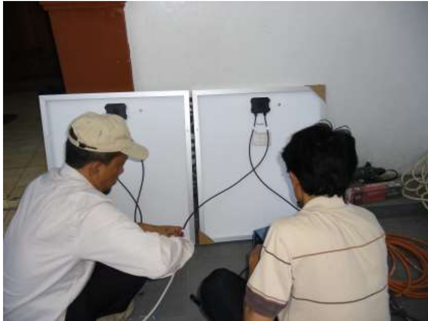
Gambar L.9. Pemasangan solar home system di PT Mahakarya Putra Indonesia.
