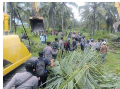
TEGANG - Sebuah backhoe dari proyek pembangunan bandara merangsek masuk ke lahannya dan mencoba merobohkan beberapa buah pohon kelapa milik warga di Sidorejo, Desa Glasah, Kecamatan Temon, Kulonprogo, Selasa (9/1).
