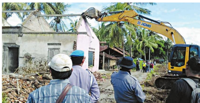
Proses perobohan bangunan di lahan NYIA.
