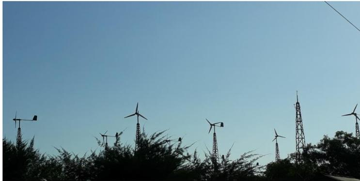
Gambar 3. Turbin Angin Grup Barat 1 kW/240 V
