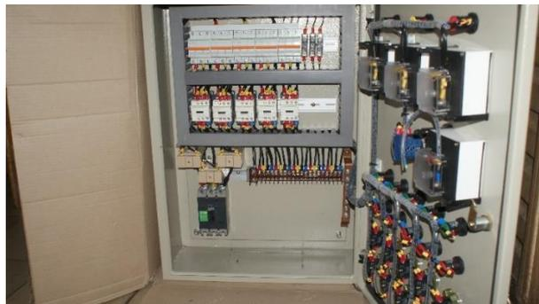
Gambar 1.7 Panel listrik tegangan menengah
