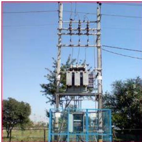
Gambar 1.3 Gardu listrik tegangan menengah
