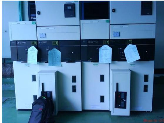
Gambar 1.4 Panel listrik tegangan menengah.
