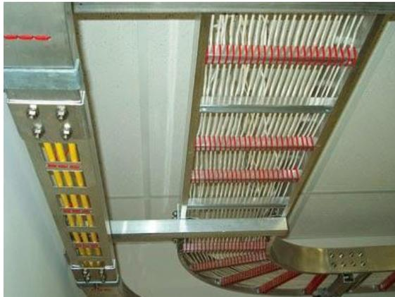
Gambar 1.25 Jalur tray kabel di langit langit bangunan.
