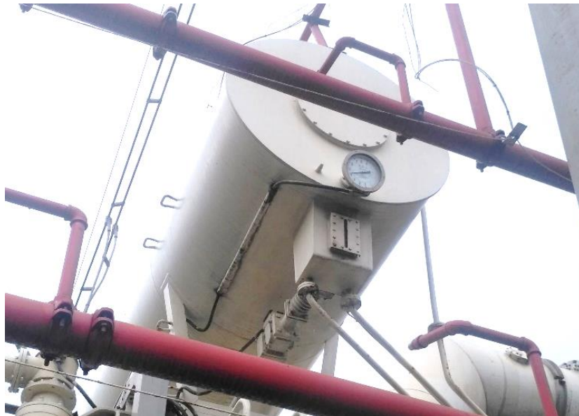
Gambar 2.12 Alat pernafasan (Konservator) Sumber: Dokumen Penelitian di PLTU 1 PACITAN
