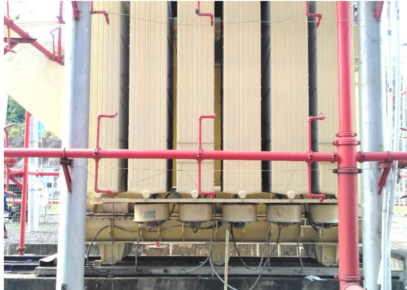
Gambar 2.11 Pendingin ( Radiator ) Sumber: Dokumen Penelitian di PLTU 1 PACITAN
