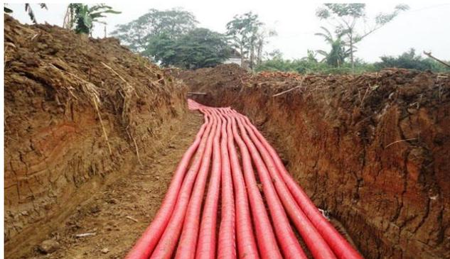
Gambar 2.5 Saluran Kabel Tanah Tegangan Menengah
