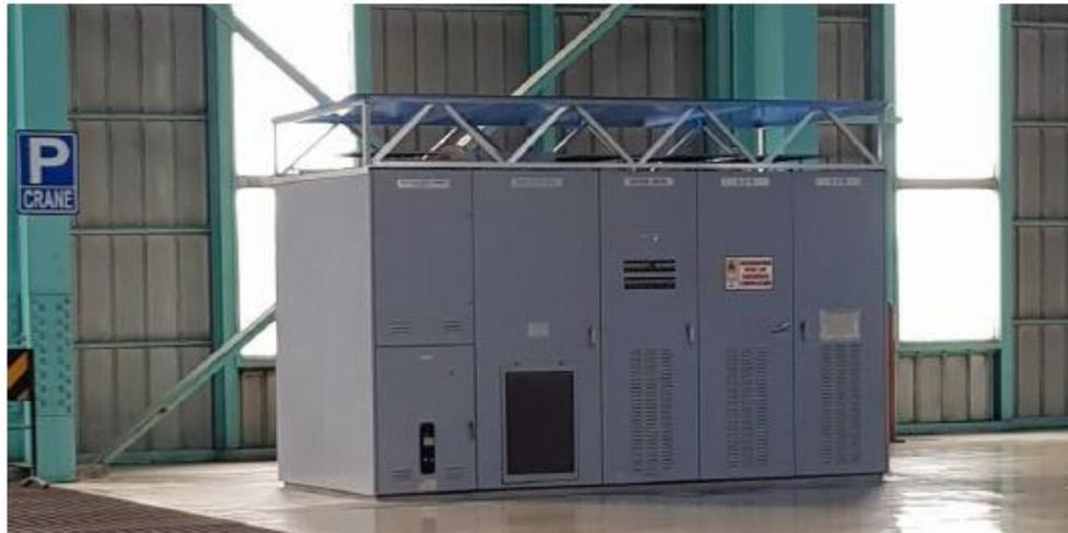
Gambar 4.5 *Automatic Voltage Regulator* (AVR) pada PLTU Unit 3 dan 4 di PJB UP Gresik
