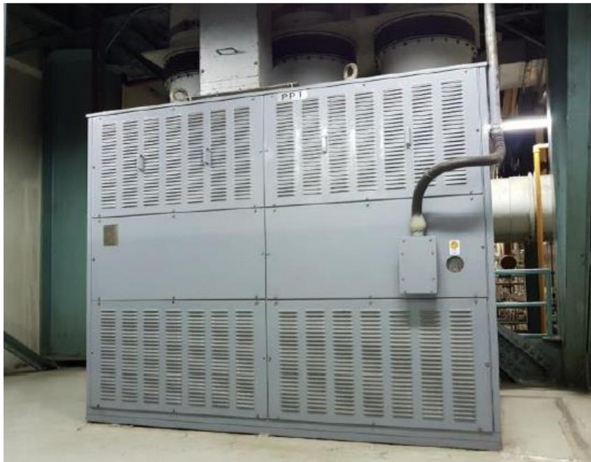
Gambar 4.2 Traformator Eksitasi (*Excitation Transformer*) pada PLTU Unit 3 dan 4
