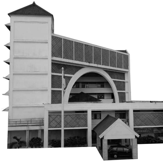
Gambar 3.2 Tampak depan bangunan
