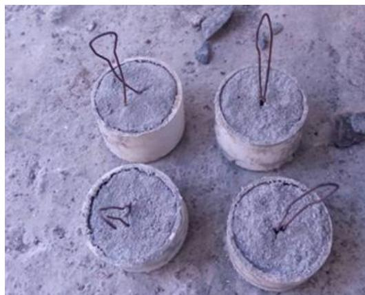
Gambar 8 Deking beton (tahu beton)
