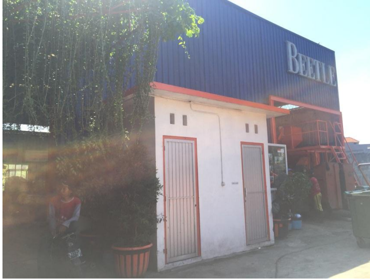
Dokumentasi keadaan tampak depan Depo Sutorejo
