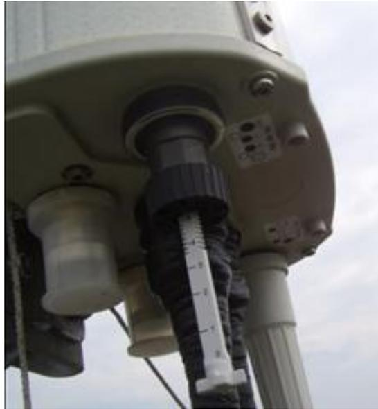
Gambar 2.7. Perangkat *electrical tilting*
