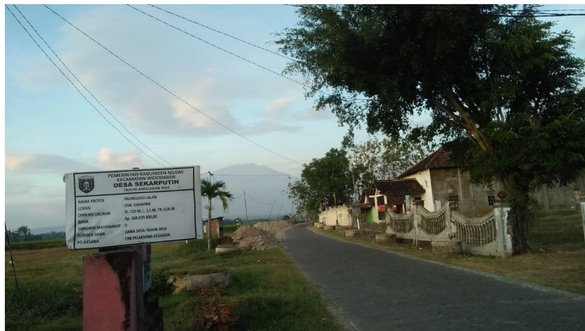
Gambar 3.3 Kondisi jalan setelah pembangunan pavingisasi
