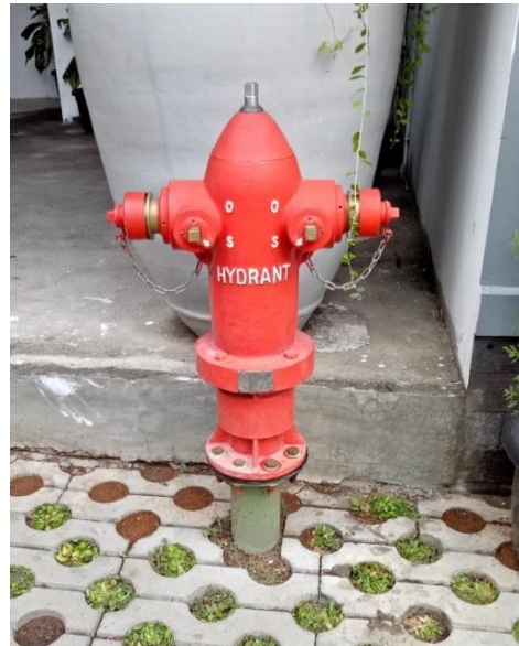
Gambar 8 Hidrant halaman
