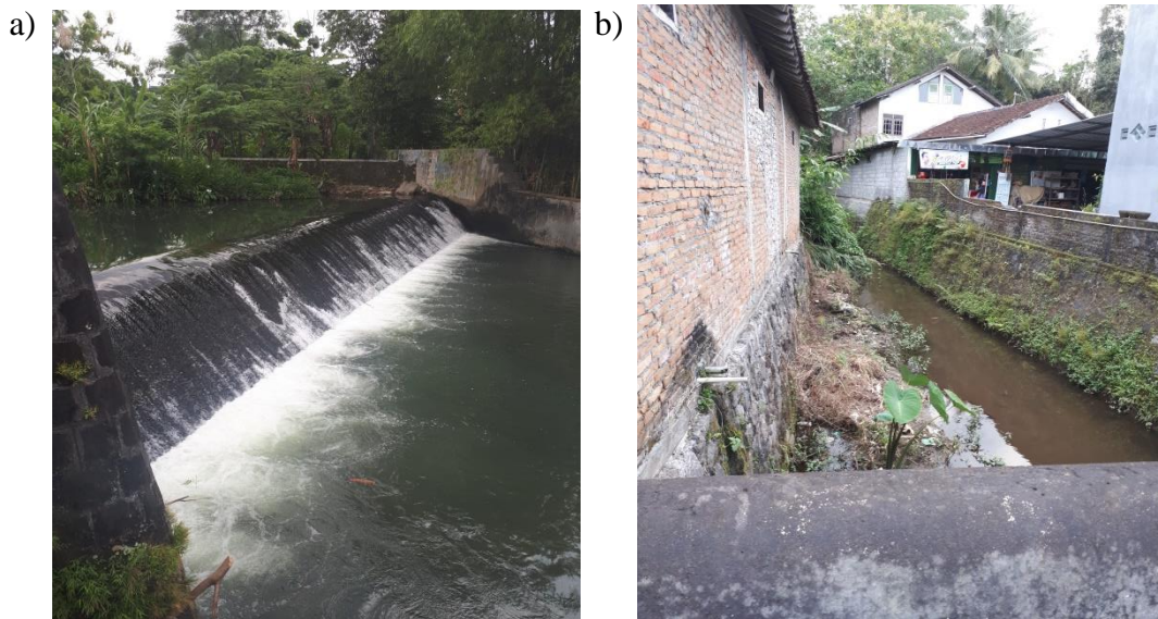
Gambar 31 Bangunan Pengendali Banjir a) DAM b) Selokan
