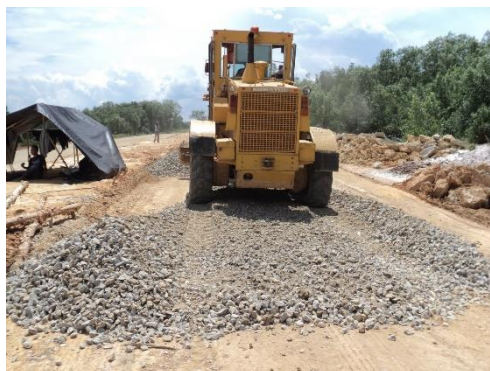
Gambar 4.13 Ilustrasi penghampanan agregat
