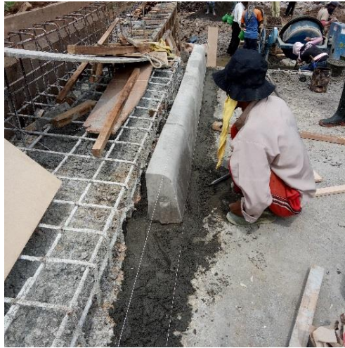
Gambar 4.23 Pemasangan kerb pracetak jenis 1 (peninggi/ mountable )
