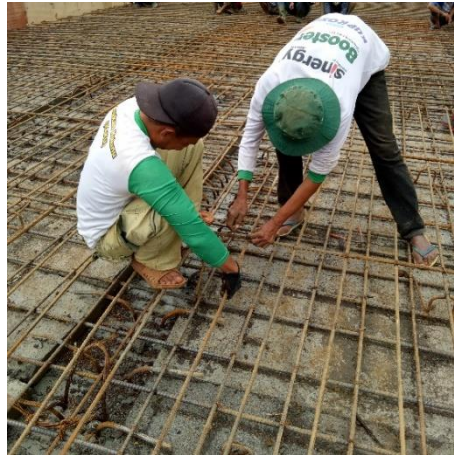
Gambar 4.19 Pemasangan kawat benrat
