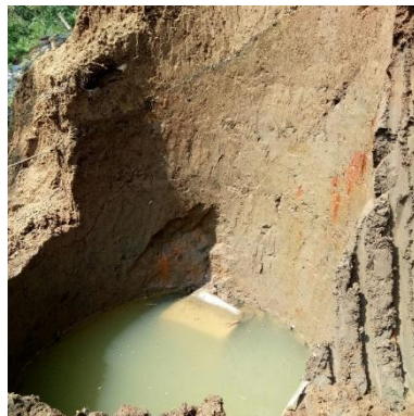
Gambar 4.6 Galian struktur pada kedalaman 2 – 4 m yang terendam air
