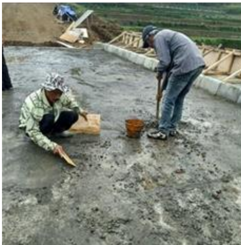
Gambar 4.25 Pembersihan lantai jembatan
