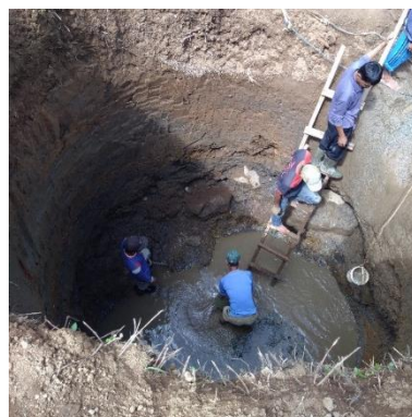
Gambar 4.7 Proses mengeluarkan air dari dalam galian
