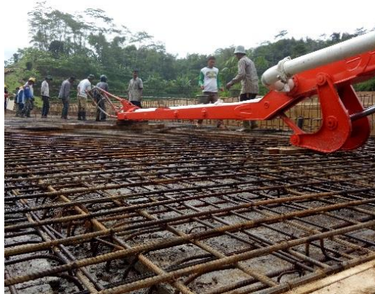
Gambar 4.21 Proses pengecoran lantai jembatan
