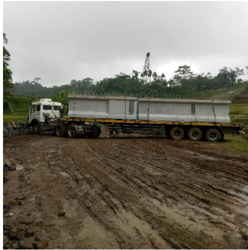
Gambar 4.17 Kedatangan girder
