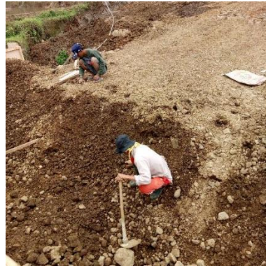
Gambar 4.8 Pekerjaan timbunan
