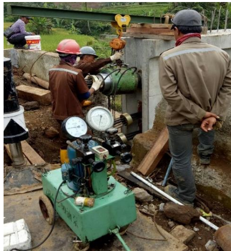
Gambar 4.18 Proses pelaksanaan stressing pada girder
