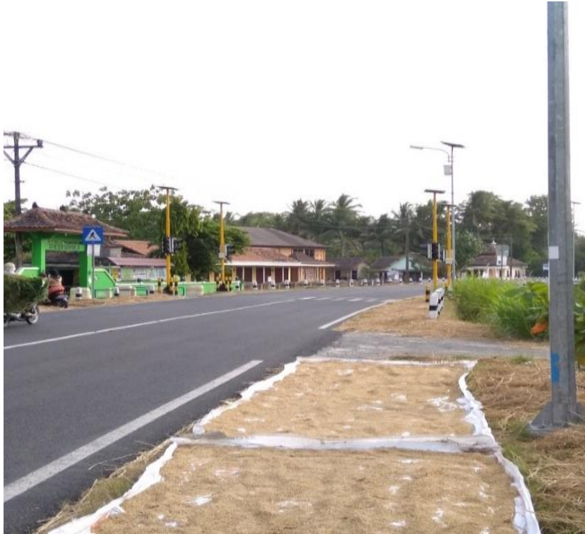
Gambar 4.8 Kondisi bahu jalan di lokasi
