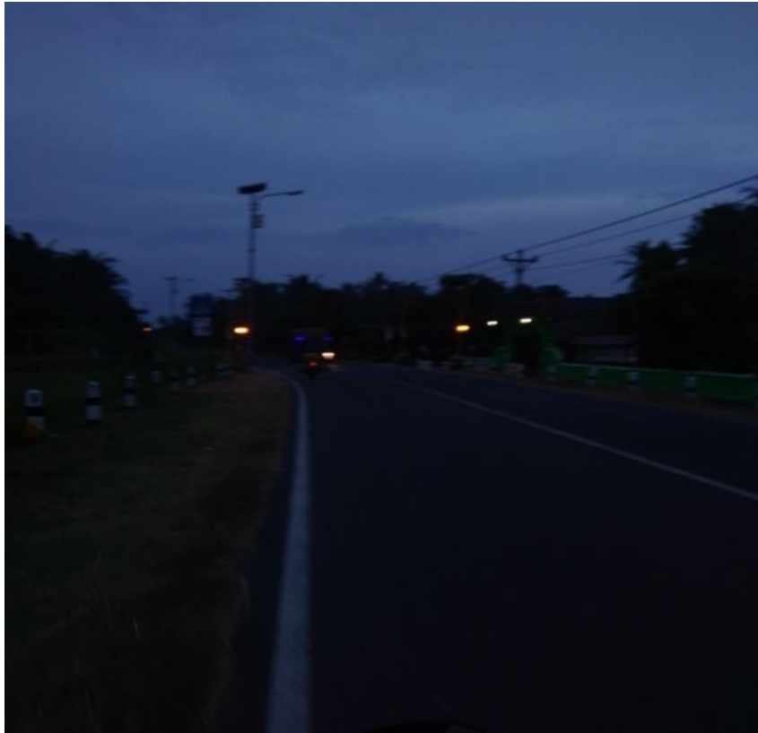
Gambar 4.9 Kondisi penerangan yang kurang
