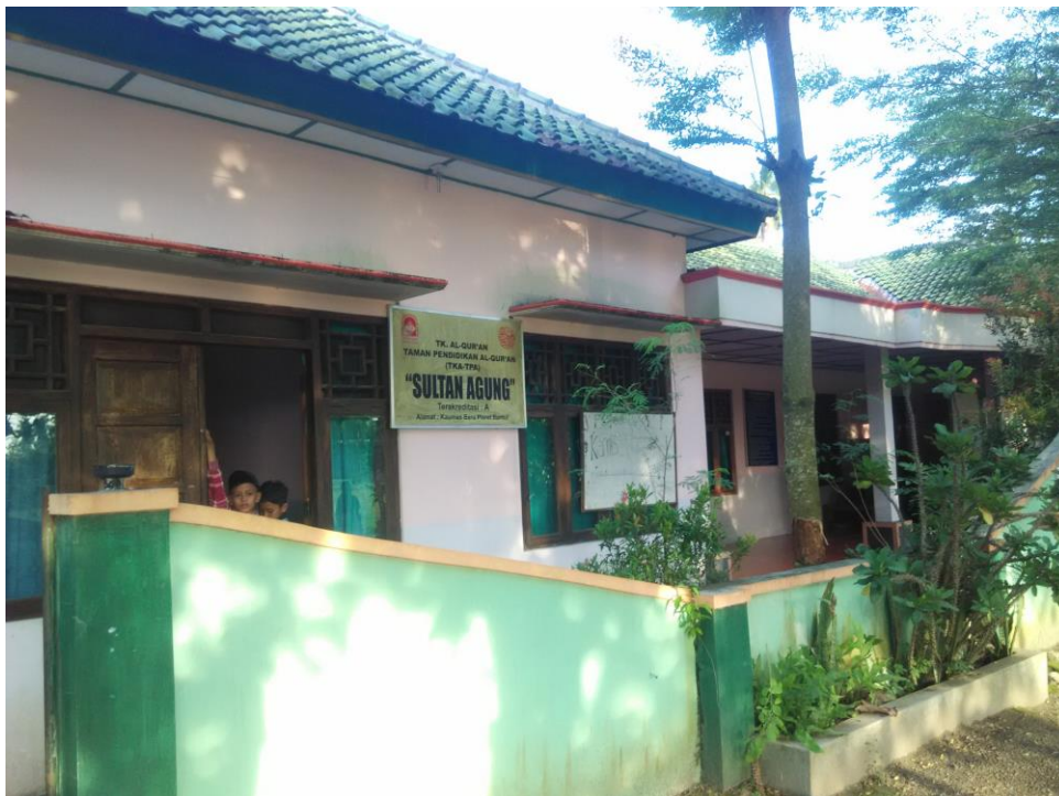
Foto Gedung TPA Sultan Agung tampak dari samping
