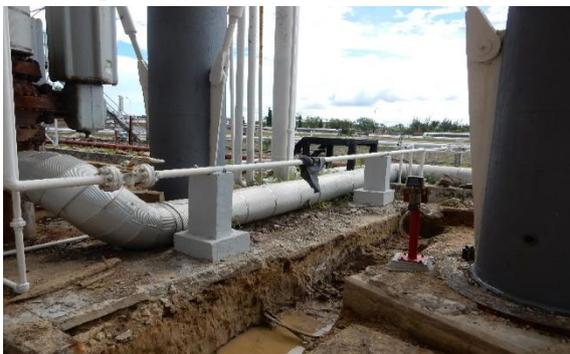
Gambar 5 Pekerjaan *maintenance* perbaikan tiang *support* pipa di bawah *tank sphere*
