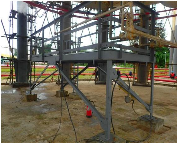
Gambar 4 Pekerjaan *maintenance* Penggantian *bordes* di bawah *tank sphere* C-20-01-B
