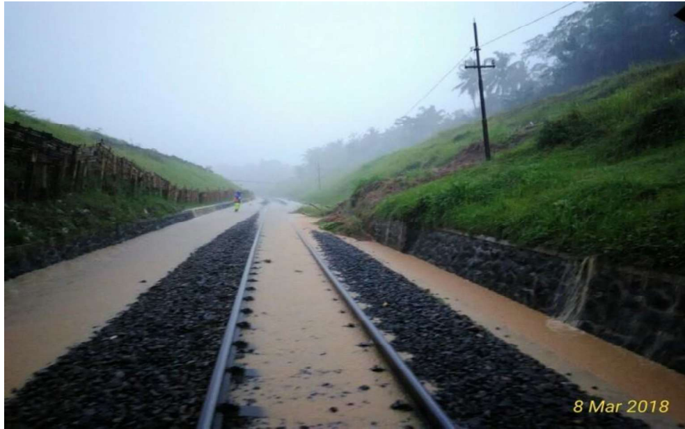
Gambar 1. 4 Bencana Longsor Jalur Kereta Api antara Stasiun Tambak Banyumas – Stasiun Ijo Kebumen
