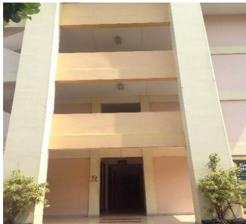
Gambar 4.4 jalur tengah bangunan gedung (tampak luar)
