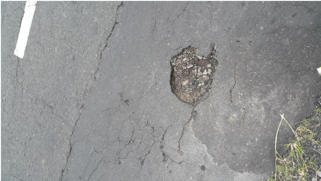
Gambar 4. Kerusakan Lubang
