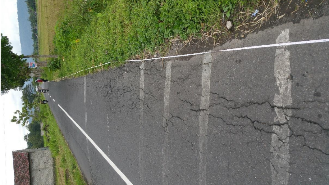
Gambar 13. Proses survei PCI
