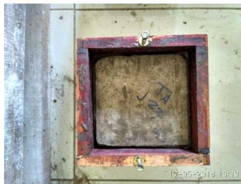
Gambar 3.45 Perbaikan kubus beton metode jacketing
