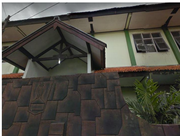
Gambar 4.13 Elemen Falling Hazard berupa kanopi kayu dan genteng di SMP Negeri 1 Pacitan
