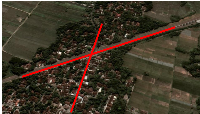
Gambar 3.2 Lokasi perlintasan sebidang JPL 716 KM 532+648
