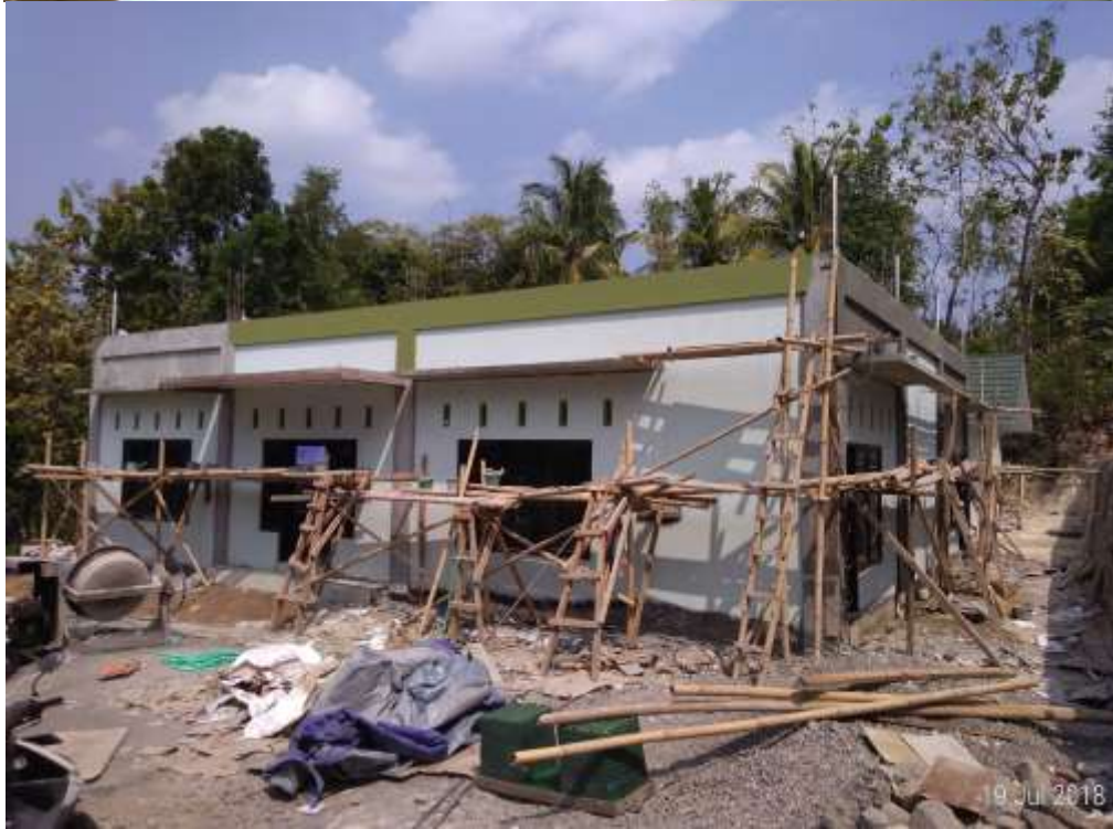
Gambar 8. Proses pembangunan Masjid Graha Al-Mubarak
