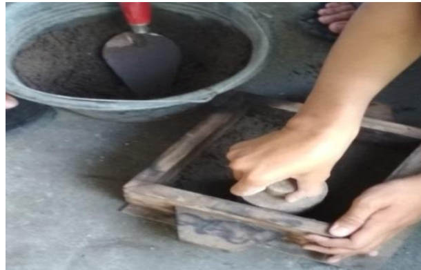
Gambar 2.7 Pembuatan pola pengecoran
