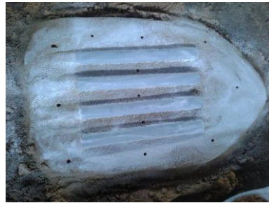
Gambar 3.1 pelapisan permukaan dalam dengan bubuk anti air.
