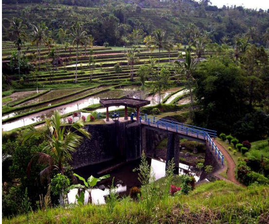
Gambar 2. 2 Saluran Irigasi / Subak di Pulau Bali
