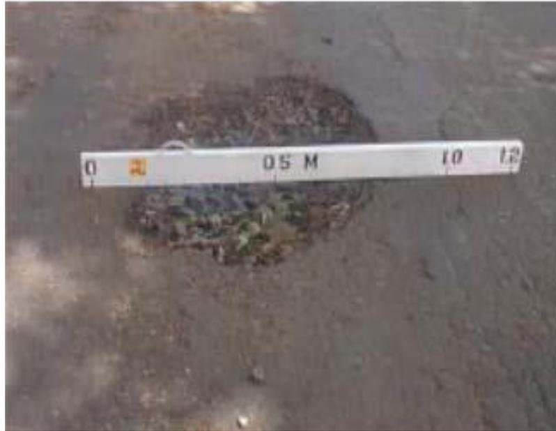
Gambar 2. 27 *Pothole* (lubang)
