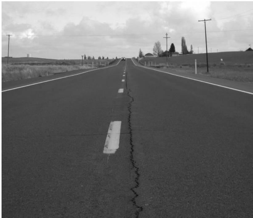
Gambar 2. 21 Retak melintang atau memanjang
