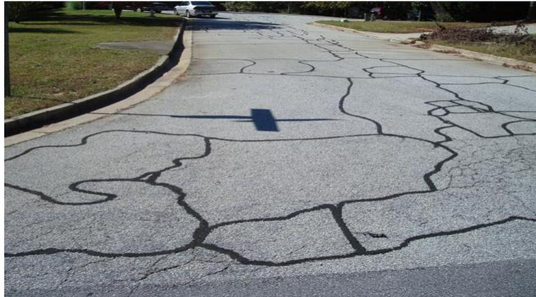
Gambar 2. 7 Retak kotak-kotak
