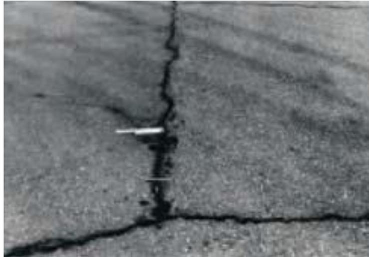
Gambar 2. 17 Retak sambung
