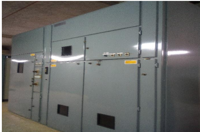
Gambar 4.5 Thyristor rectifier
