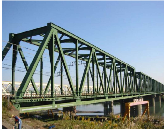
Gambar 2.3 Jembatan kereta api ( Lin dan Yuda, 2017).
