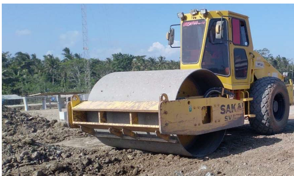
Gambar 4.17 Proses pemadatan tanah menggunakan vibro roller
