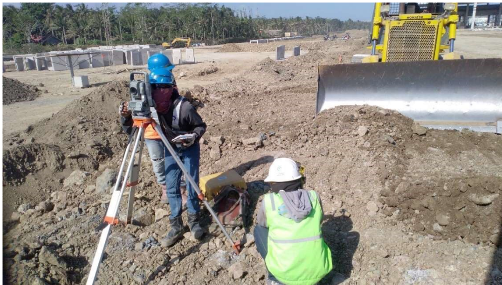
Gambar 4.13 Pekerja sedang melakukan pengukuran elevasi timbunan
