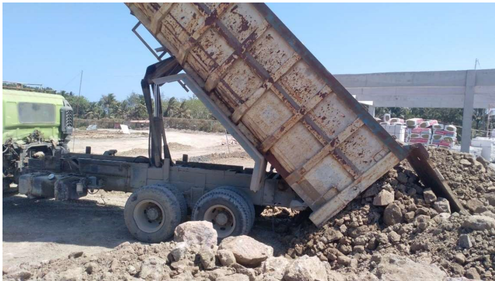
Gambar 4.10 Proses pembuangan tanah dari DT
