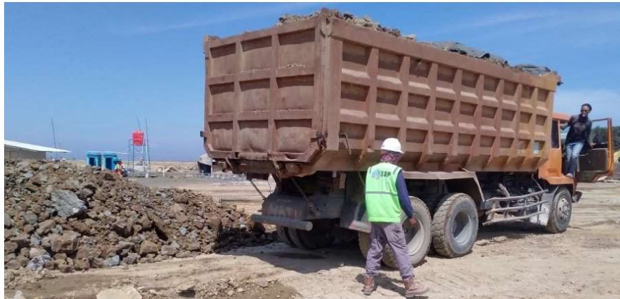
Gambar 4.9 Driver DT akan menggulung terpal sebelum melakukan pembuangan tanah
