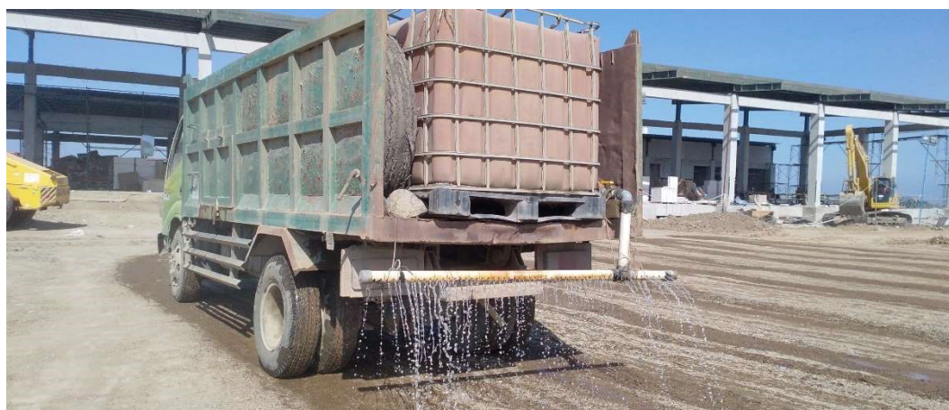
Gambar 4.18 Proses penyiraman air pada timbunan tanah
