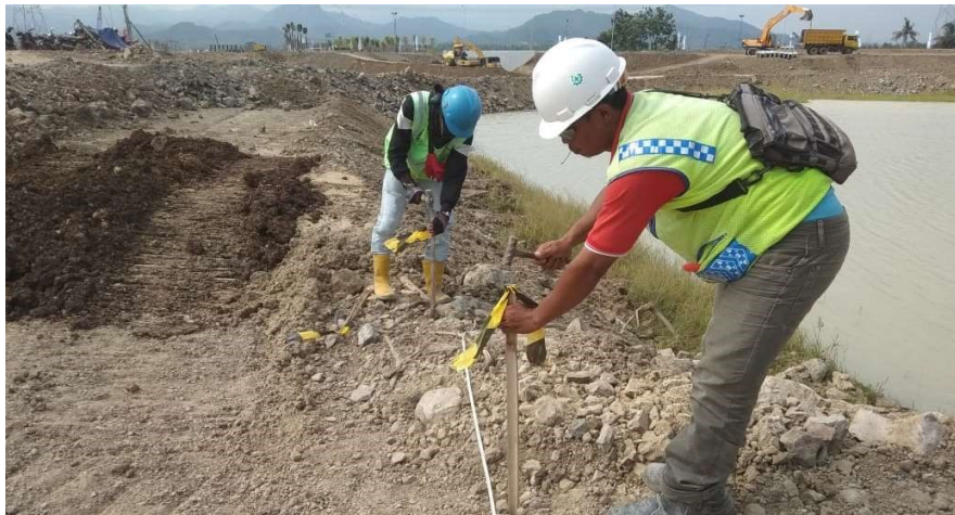
Gambar 4.14 Pekerja sedang melakukan pemasangan patok
