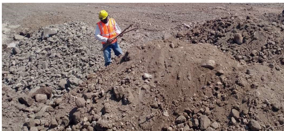
Gambar 4.11 Pekerja sedang melakukan pembersihan sampah setelah pembuangan dari DT
