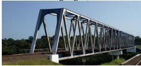
Gambar 11 Jembatan baja KA Mbeling II
