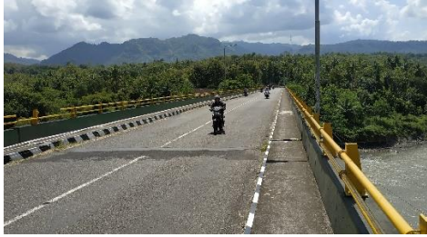
Gambar 10 Jembatan beton Kreo (Kebun Agung II)
