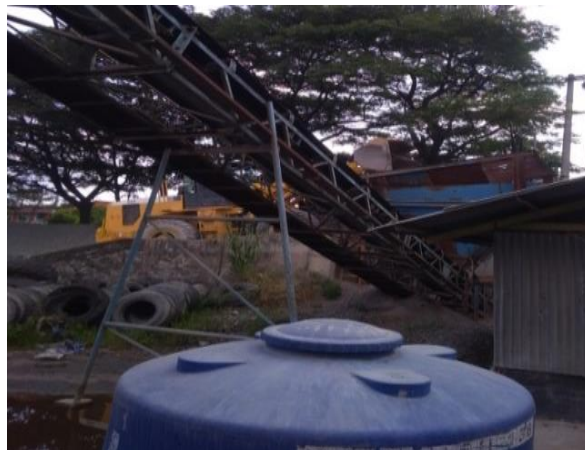
Gambar 4.5 Pengangkutan material kedalam bak penampungan
